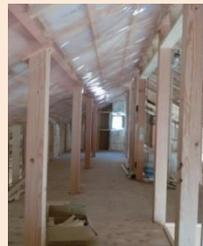
壁天井のグラスウールの施工状況です。厚み 100mm で密度は 16k を使用しました
