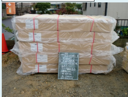
床下断熱材厚 80mm
