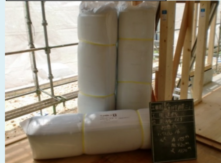
天井断熱材厚 155mm
