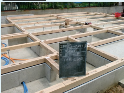
床下断熱材厚 80mm
