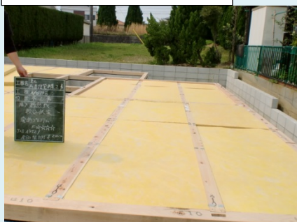
床下断熱材施工状況
