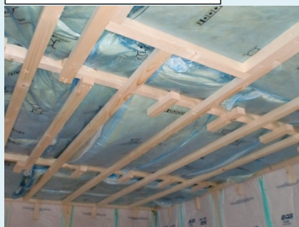
壁断熱材施工状況
