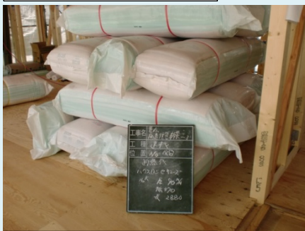
壁断熱材厚 90mm
